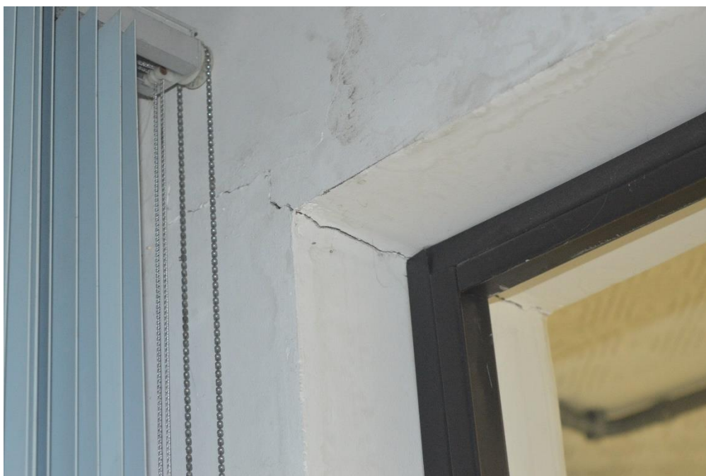
Figura 5 - Ampliação da CPD -Trincas no reboco
