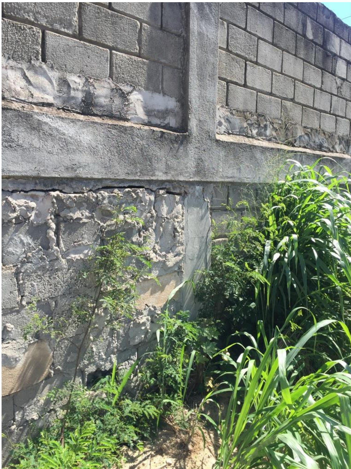
Figura 69 - Prédio Anexo - Parede Externa - Pilar Não-Identificado 001
