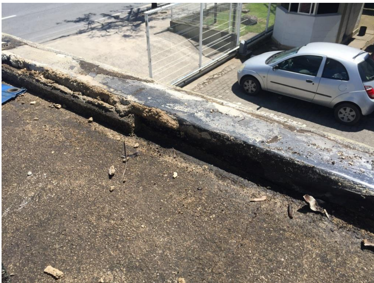
Figura 51 - Vista da laje nova laje pré-moldada e laje maciça existe por cima.
