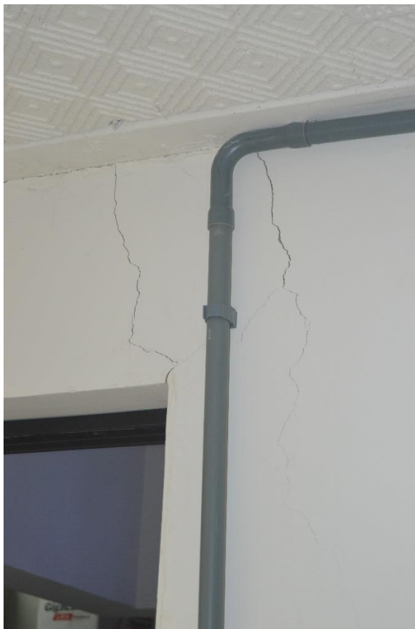
Figura 5 - Ampliação da CPD -Trincas no reboco
