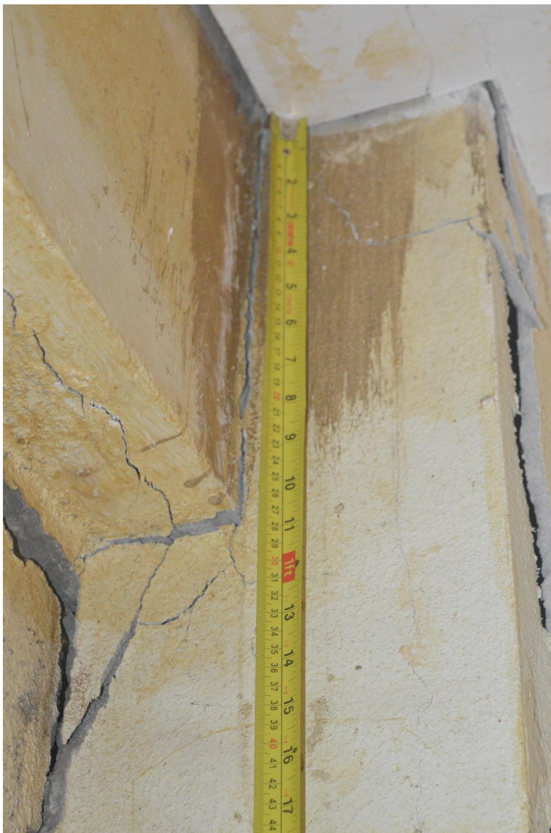
Figura 25 - Prédio Anexo - Altura da viga por baixo da laje
