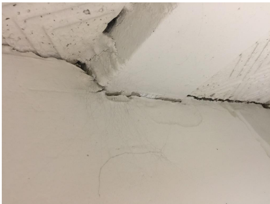
Figura 50 - Laje pré-moldada embutida na viga existente
