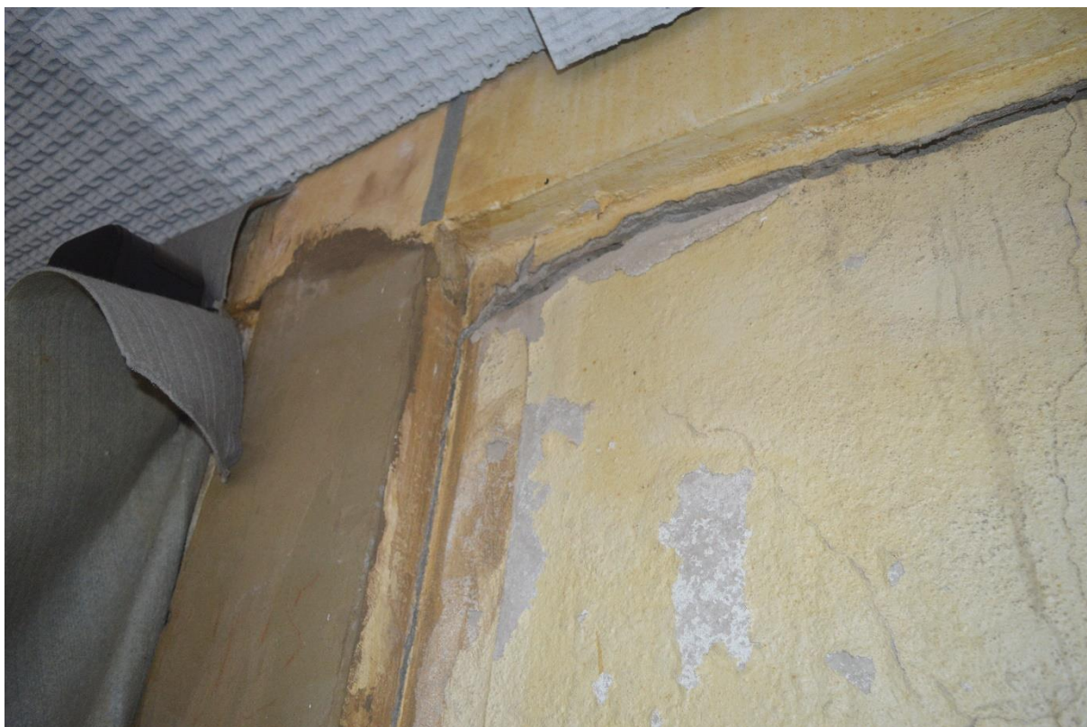
Figura 68 – “Pilar” da região do Auditório
