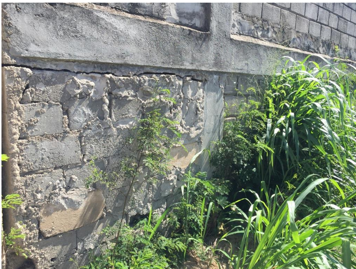
Figura 70 - Prédio Anexo - Parede Externa - Pilar Não-Identificado 002
